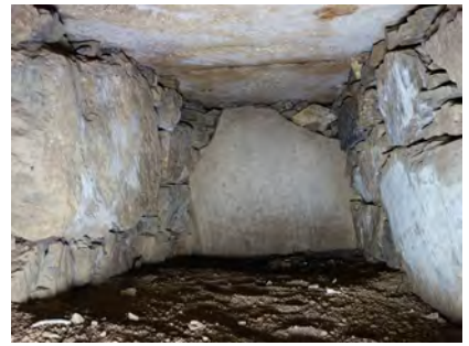
石室内部（玄門より）
